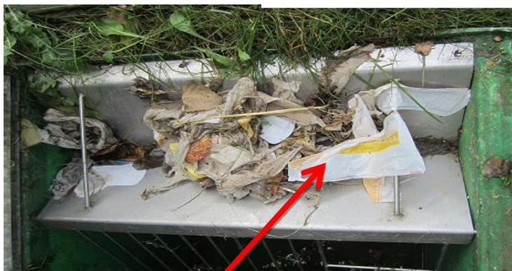
**Dans le réseau, les lingettes forment de la filasse qui obstrue les pompes servant à relever les eaux usées vers la station d'épuration.**
